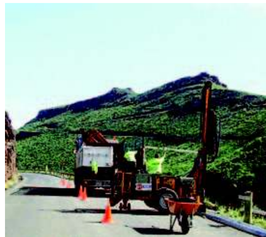
Imagen de archivo del acondicionamiento de una vía, en La Gomera. / DA
