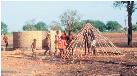
Inici de la construcció de la teulada Inicio de la construcción del tejado
