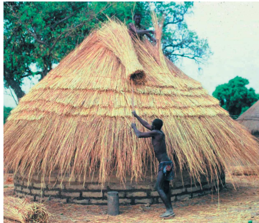
Col·locació de la teulada a la casa tradicional Colocación del tejado en la casa tradicional
